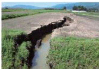
大きくひび割れた水田。 幅2mほどのひび割れが 数百mに渡っている。 現在は，基盤整備中(阿蘇市)
