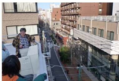
写真12 似て非ワークス・アンテナ設置
